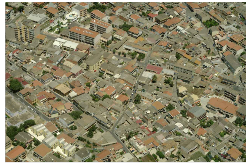
Isolato 10 - Via Gorizia, via Trieste, vista da Sud
